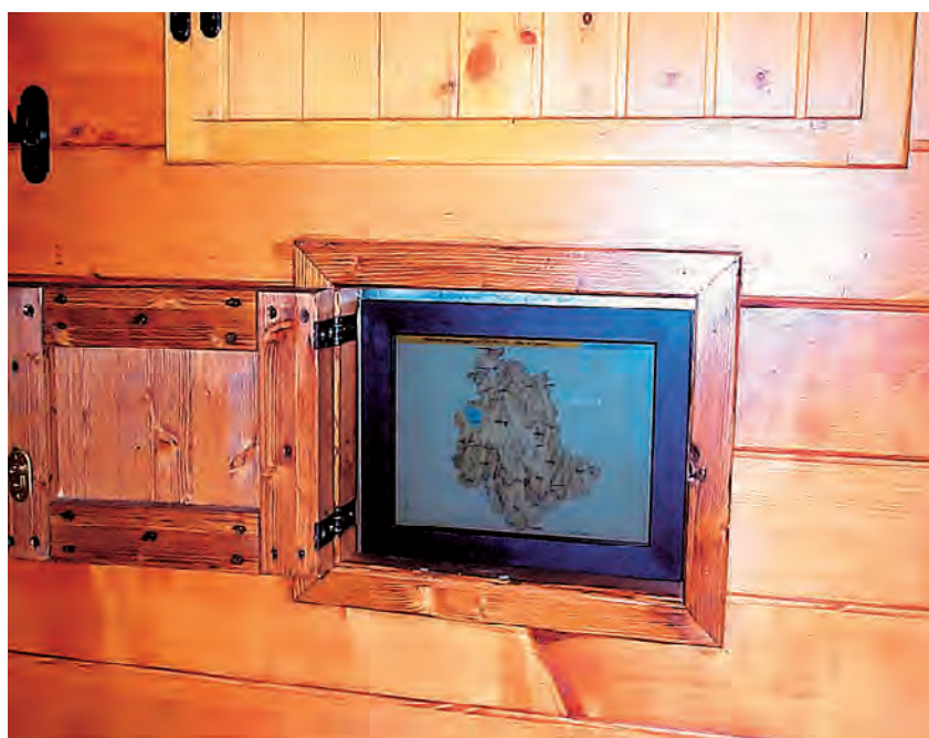
Centralina di monitoraggio chimico: particolare del Touch Screen.
